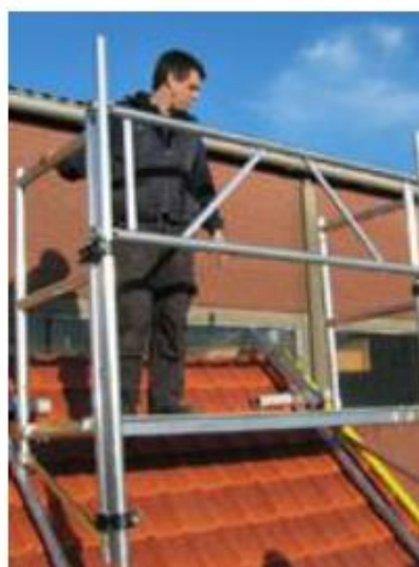
Dubbele leuningschoor plaatsen. De set inclusief kantplankset
